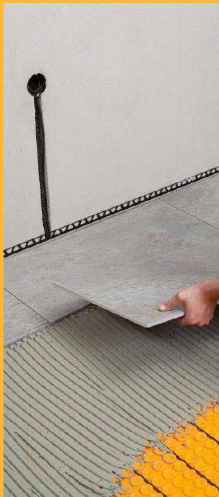
Pavimento radiante
